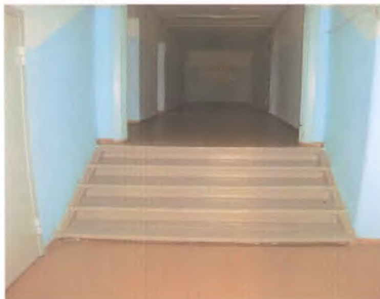
20. Лестница (внутри здания)
