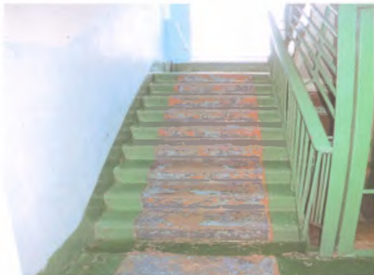
21. Лестница (внутри здания)
