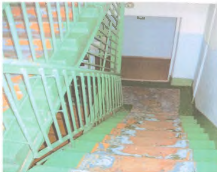
22. Лестница (внутри здания)
