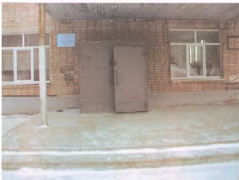
12. Дверь (входная) и входная площадка (перед дверью)
