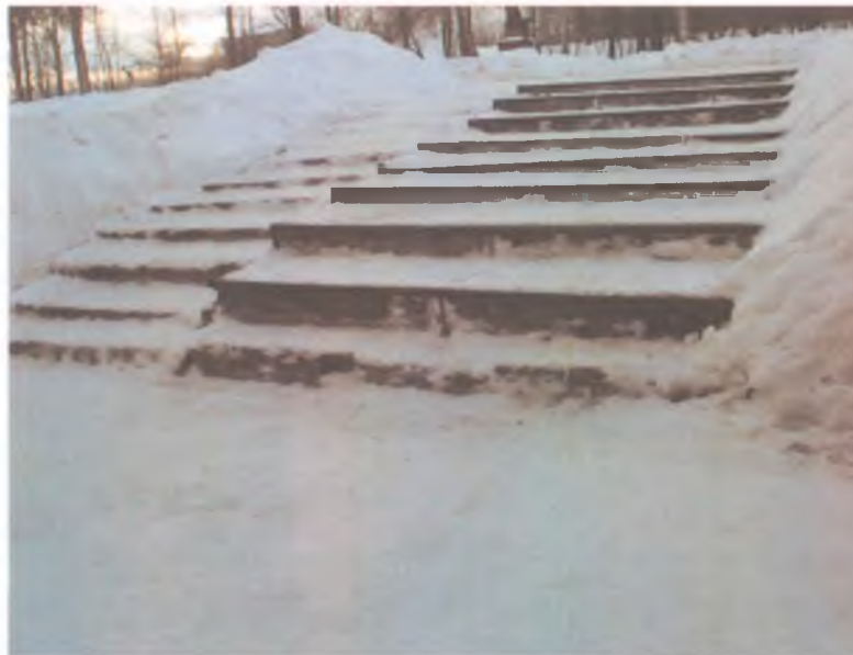
10. Лестница на территории (наружная)
